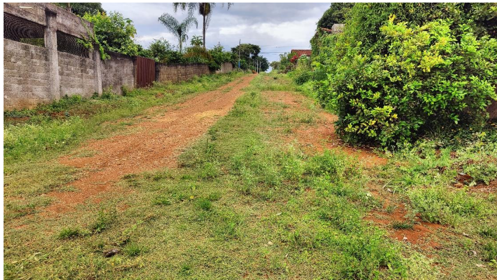
Foto 06: Rua Sinésio Costa Alves, para execução da pavimentação.
