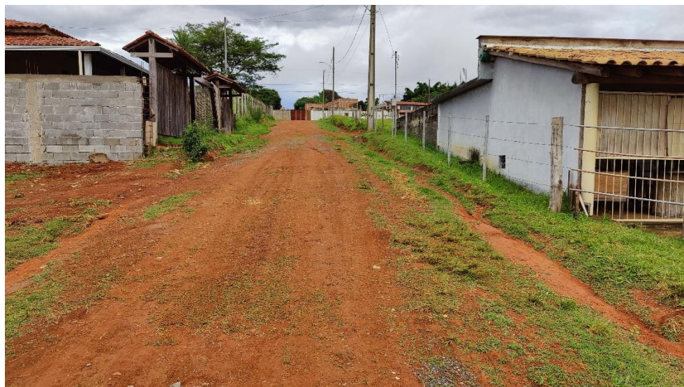
Foto 04: Rua Antônio R. Oliveira, para execução da pavimentação.
