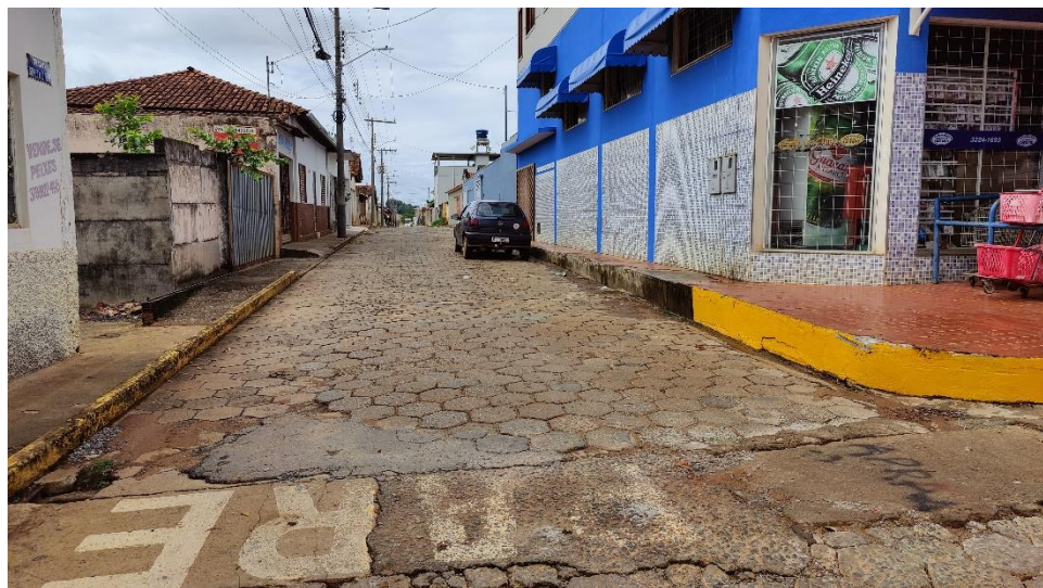
Foto 01: Rua Sidney de Oliveira, para execução da pavimentação.
